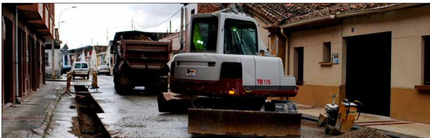
Imagen de las recientes obras en la calle La Milagrosa
