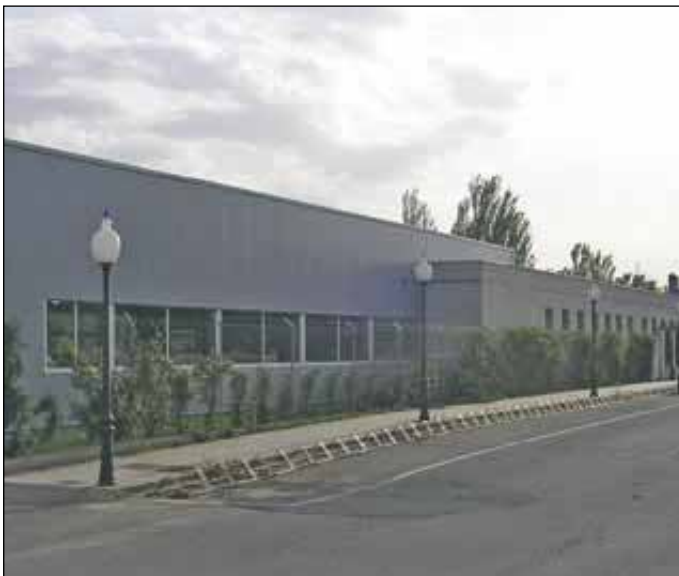
Instalaciones de las Piscinas Municipales
